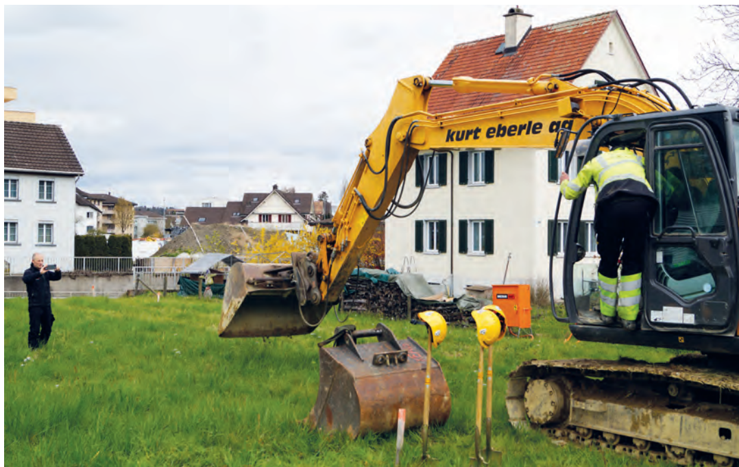
Petra Manser hebt nach dem Spatenstich die erste Schaufel aus, Hampi Manser (l.) hält den Moment fest.
